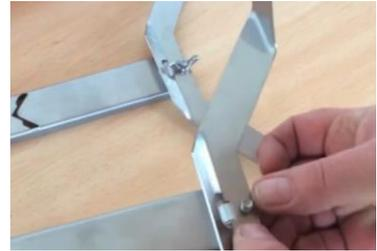
2. Clipser la partie haute du cadre sur chacun des montants latéraux (section en « U » vers l'extérieur)
